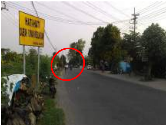
Gambar 3.4 Kondisi Bahu Jalan Segmen 3
