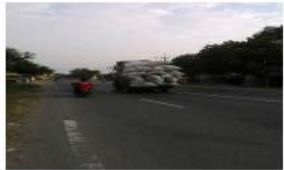
Gambar 3.3 Kondisi Bahu Jalan Segmen 2
