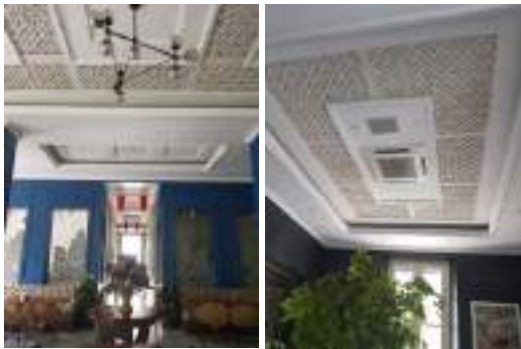
Gambar 3. Infil Desain Plafon pada Rosti Resto & Café guna Penyisipan Instalasi pada Fungsi Baru (Sumber Foto: Penulis, 2022)
