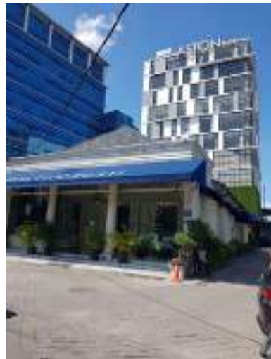
Gambar 5. Bangunan Rosti Resto & Café dengan Kekuatan Identitas Klasik Jejak Kemewahan dan Kekayaan yang beradaptasi Perkembangan Modern disekitarnya (Sumber Foto: Penulis, 2022)
