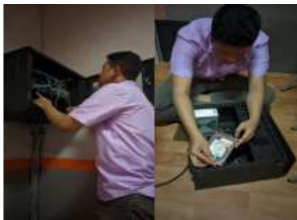
Gambar 7 Dokumentasi pengerjaan Troubleshooting
