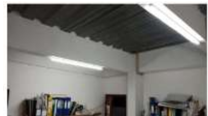
Gambar 13 Tampak Kondisi Ruang Staff Struktur
