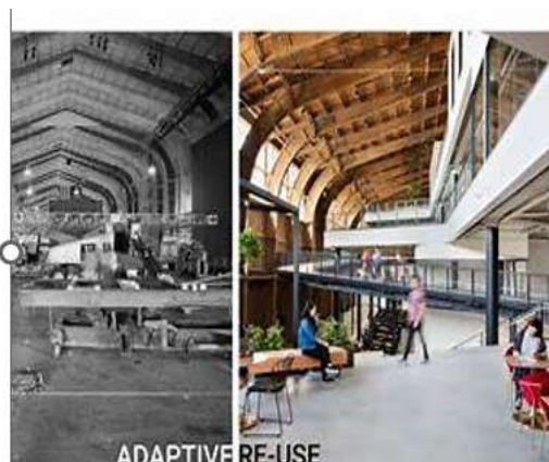
Gambar 2. Bangunan Adaptive Reuse Sumber : Penelitian mandiri 2026
