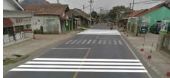
Gambar 3.6 Kondisi Tikungan KM 1+650 Sesudah Dipasang Pita Penggaduh ( Rumble Strip )
