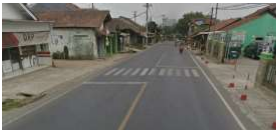
Gambar 3.5 Kondisi Eksisting Tikungan KM 1+650 Sebelum Dipasang Pita Penggaduh ( Rumble Strip )
