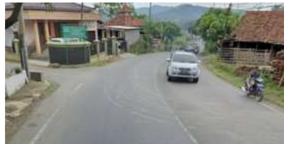
Gambar 3.7 Kondisi Eksisting Tikungan KM 1+850 Sebelum Dipasang Pita Penggaduh ( Rumble Strip )
